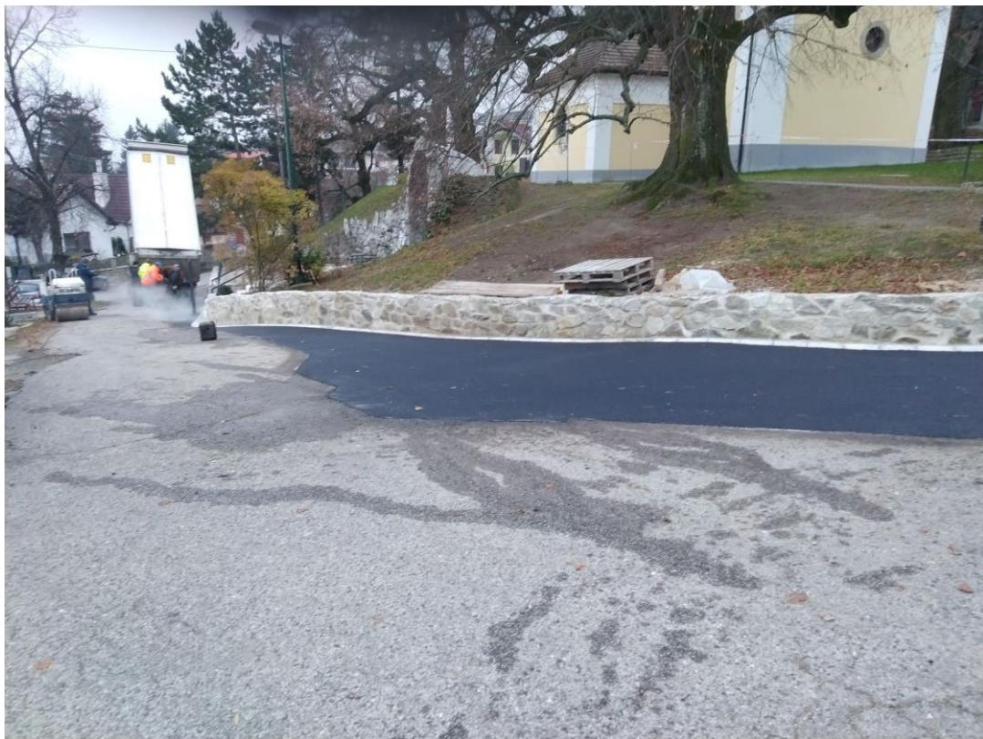
Pokládka nových asfaltov
