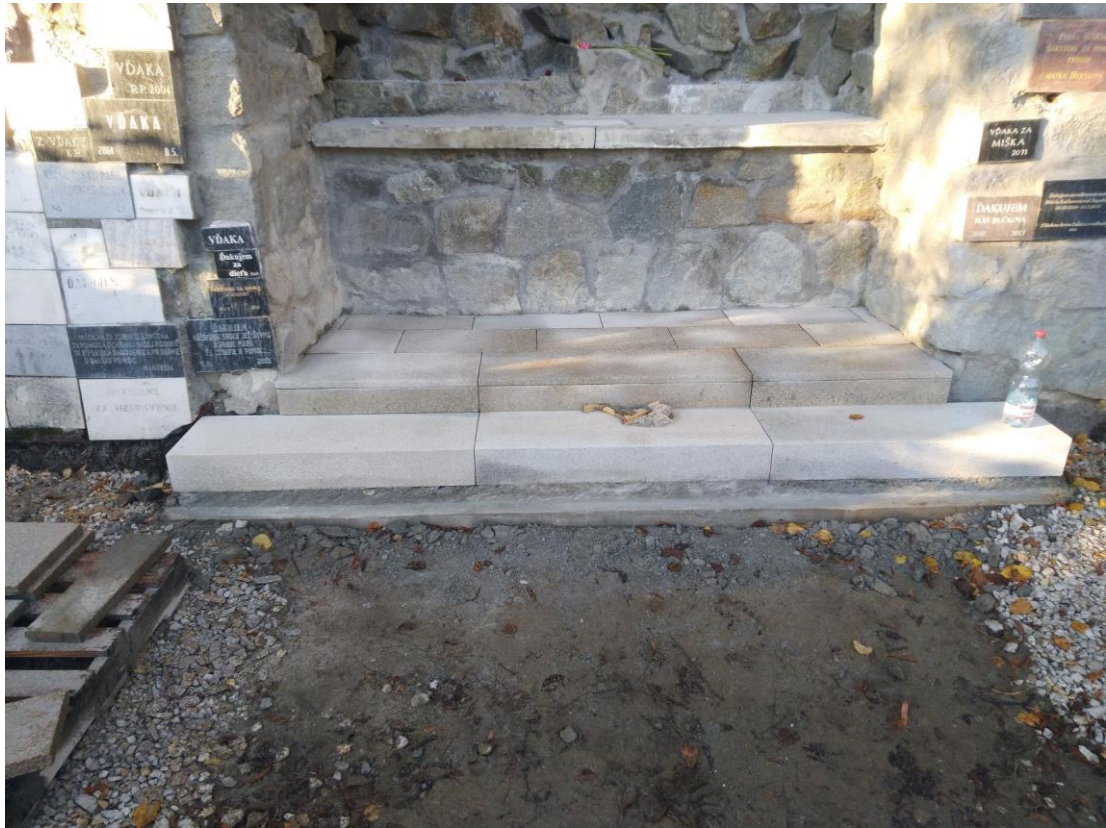
Obnovený oltárny stupeň, nový schod zo žuly a nový obklad oltárneho stupňa.
