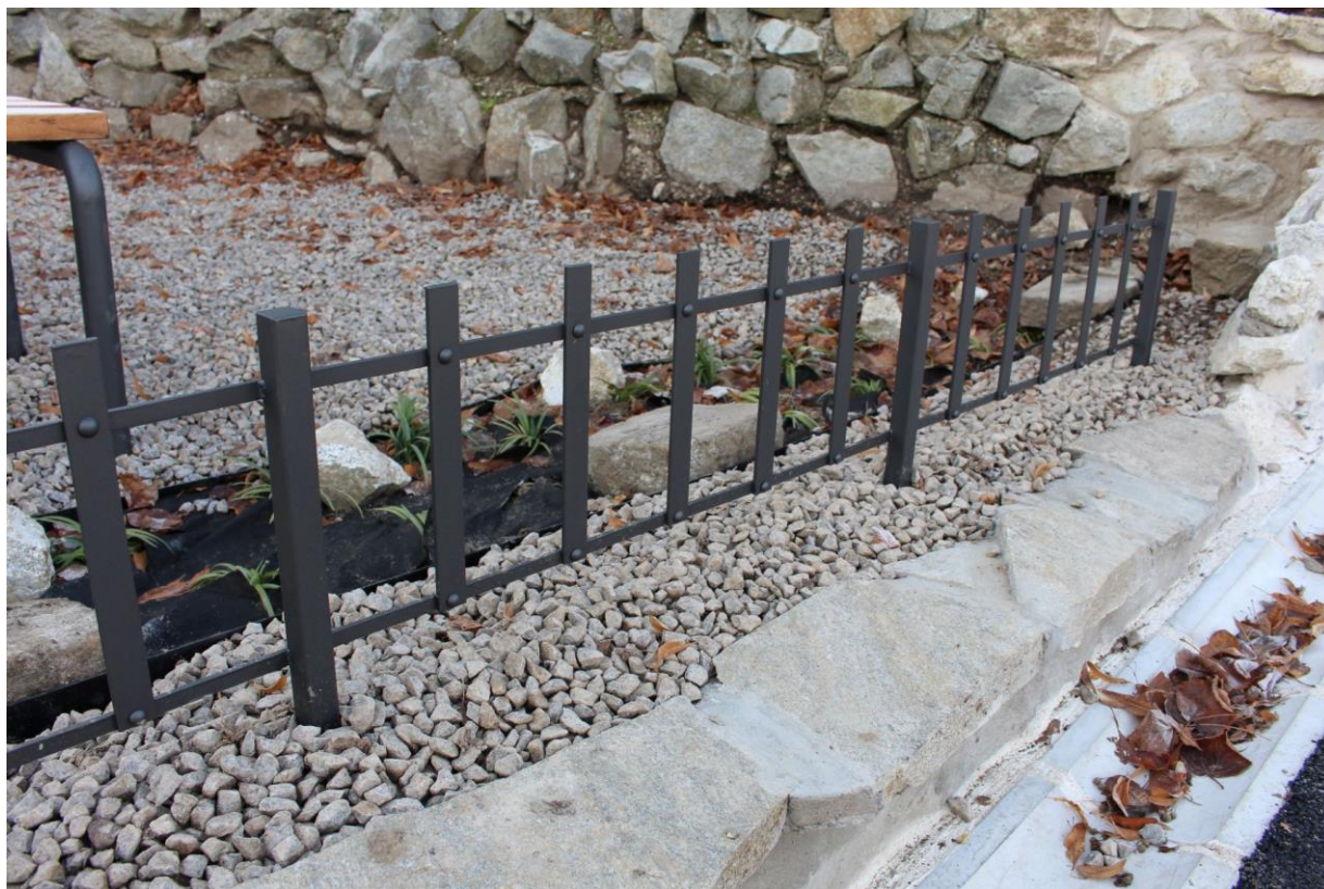
Nové oplotky na korunách oporných múrov jaskyne
