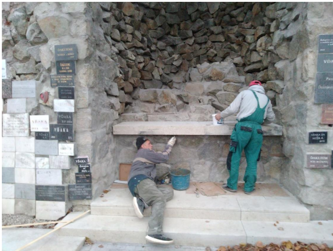
Montáž žulového obkladu oltárnej dosky jaskyne
