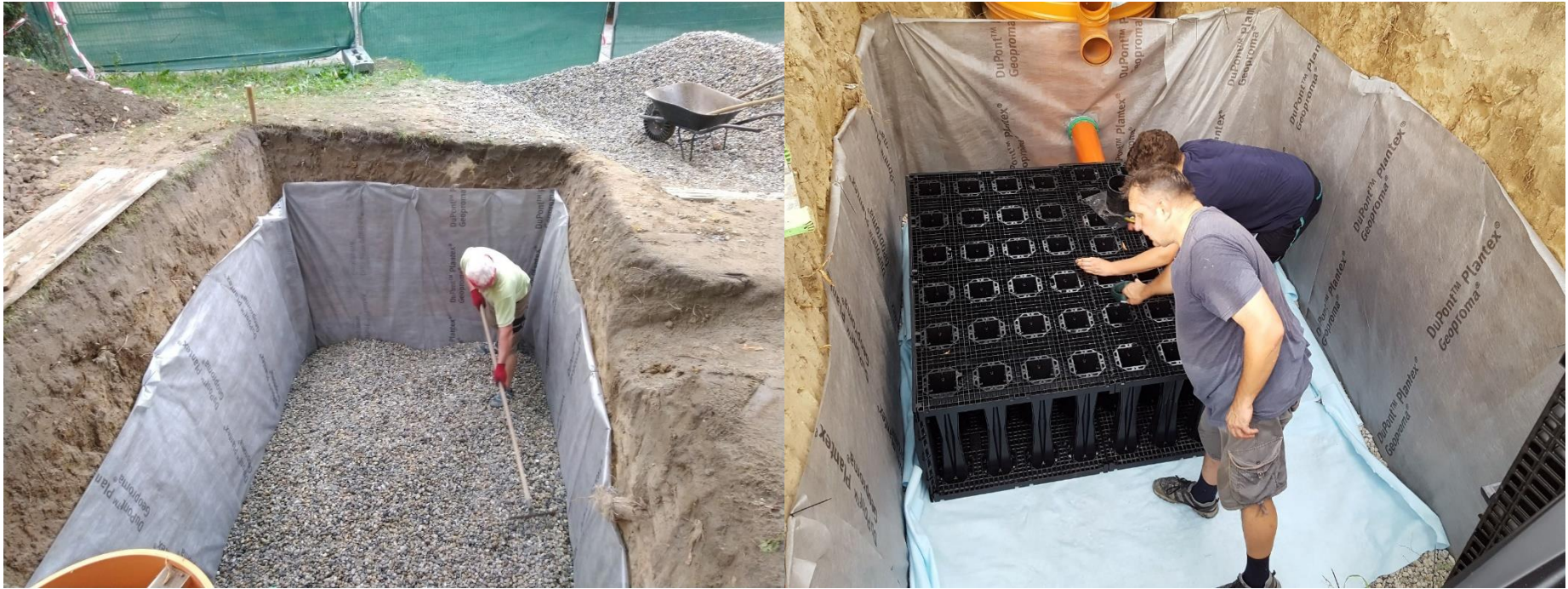
Vyrovnávanie štrkového podsypu pod vsakovacie bloky Rausikko, montáž vsakovacích blokov.
