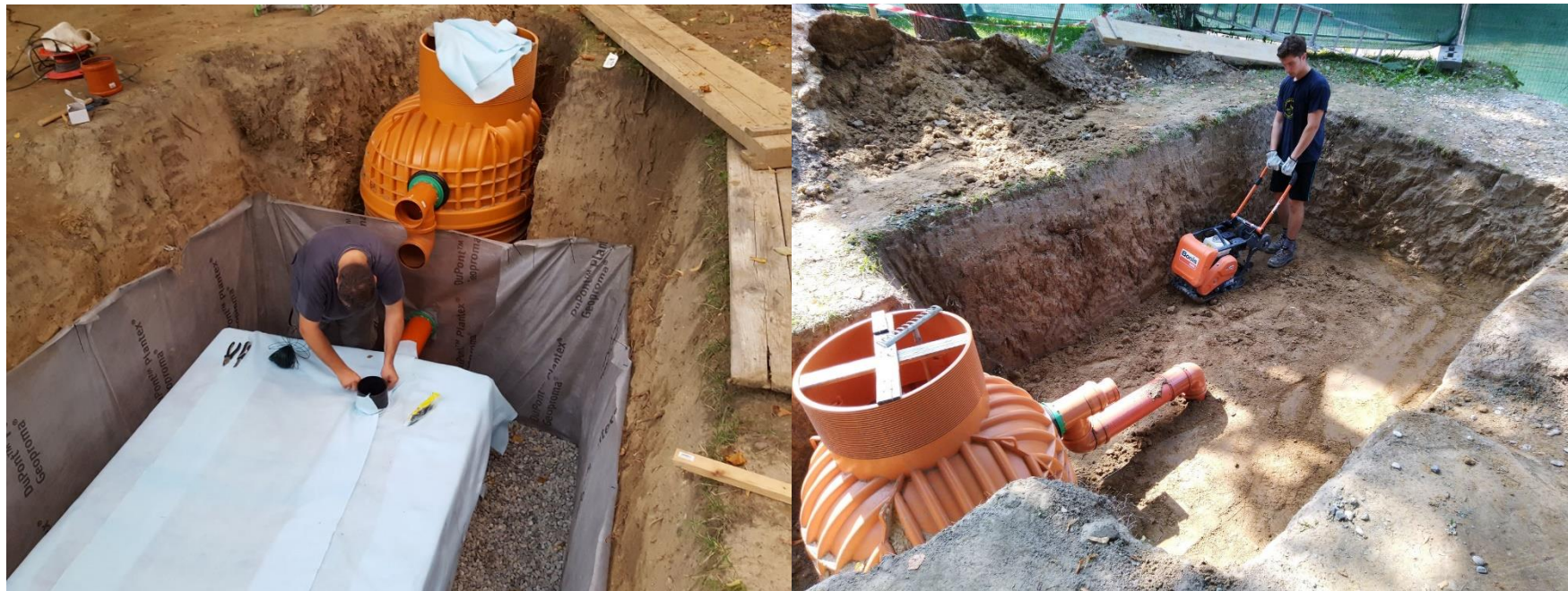
Obalenie vsakovacích blokov geotextíliou, zásyp a hutnenie vsakovacej jamy.
