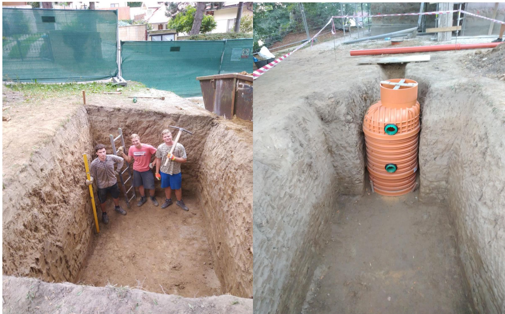
Výkop 20 m 3 vsakovacej jamy, osadenie filtračnej šachty.
