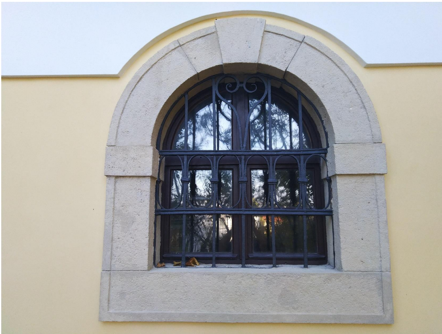
Obnovené kamenné ostenia, mreže a okná.
