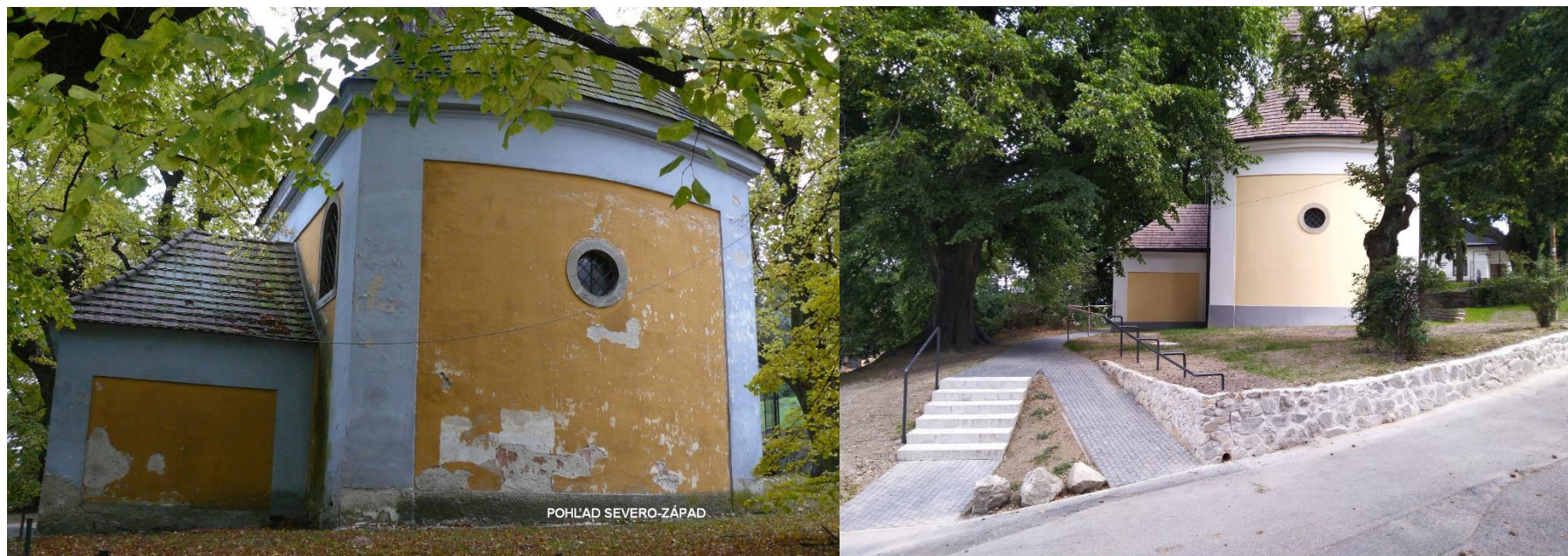
Kaplnka pred obnovou a po obnove...
