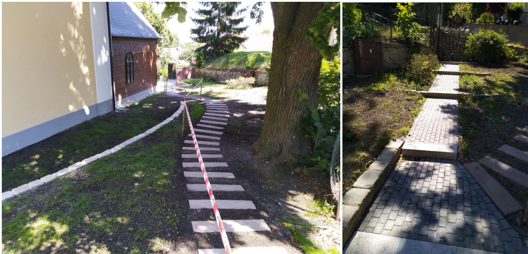
Nové chodníky: Šlapákový chodník popri severnej strane Kaplnky, chodník do fary.
