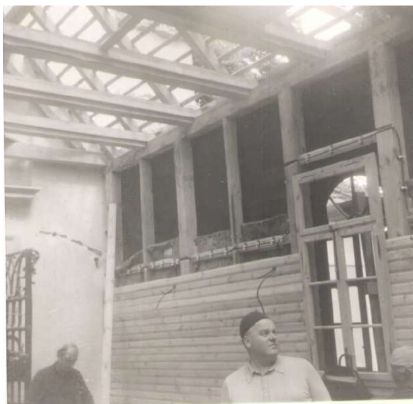
Farár prof. ThDr. Jozef Beitel pri kontrole prác na novej prístavbe, august 1974.
